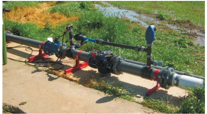
Рис. 5 – Система контролю тиску та вузол для внесення добрив
