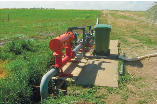
Рис. 4 – Автоматичний фільтр, система контролю тиску та вузол внесення добрив системи крапельного зрошення рису
